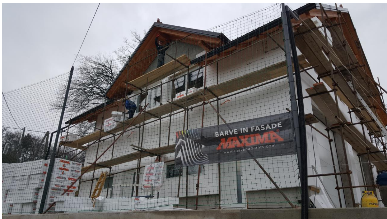
Gasilski dom dobiva novo preobleko, vsa dela pa opravljamo članice in člani PGD Primskovo (februar 2017)
